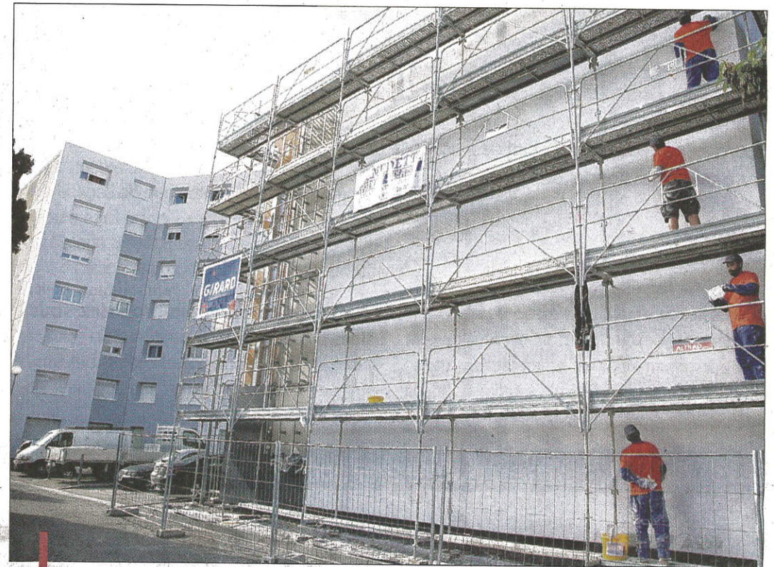
Les employés de l'entreprise avignonnaise Benedetti sont à l'œuvre sur les façades des bâtiments, recouverts d'une couche d'isolant thermique et repeints en une teinte plus claire. / PHOTOS CYRIL HIÉLY
